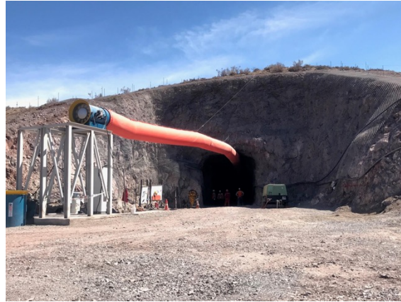
Arqueros – Construction 80% Nittetsu | 20% Fondo de Inversión Privado Talcuna
